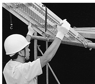
① 下段足場板のフックを架けます。
