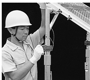
② 中間支柱の高さを荒調整します。
