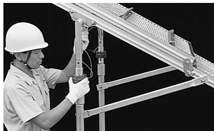
⑥ 中間支柱の高さの微調整を行ない、方杖と上・下足場板の連結金具を確実に固定して完成です。
