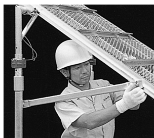
③ 中間支柱の方杖を下段足場板に仮固定します。
