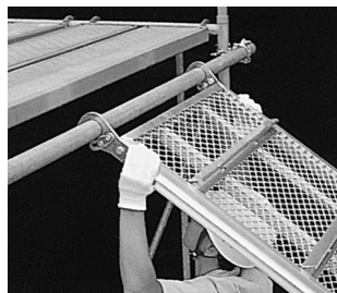
④ 上段足場板のフックを架けます。
