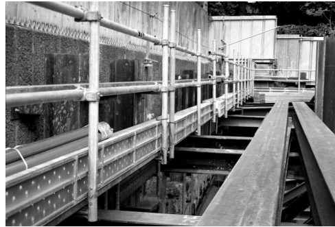
腹起し通路 AT-500 …7.8kg (2枚敷) H鋼サイズ:200H~450H
