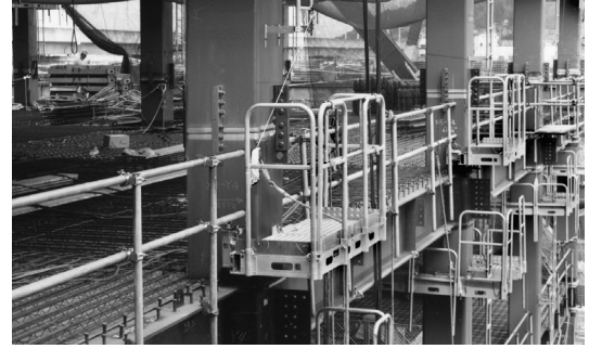
コーナー型 CST-PC...75.0kg [許容荷重:1.96kN(片側)]
