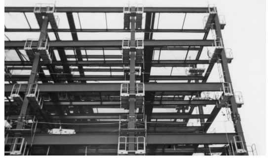
■コーナー型 CST-BC…70.0kg [許容荷重:1.96kN (片側)]
