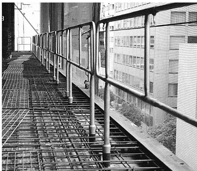
コンクリート打設前
