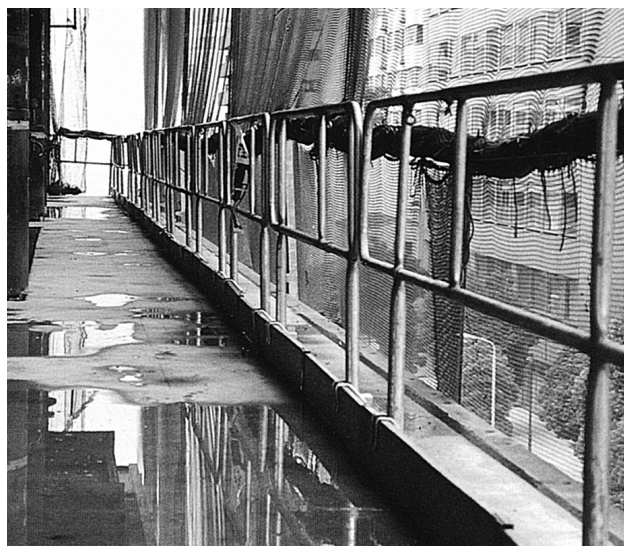
コンクリート打設後(巾木付)
