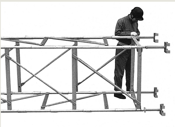
⑤ヘッドスピンドルを差し込み、セーフティストラップで固定します。
