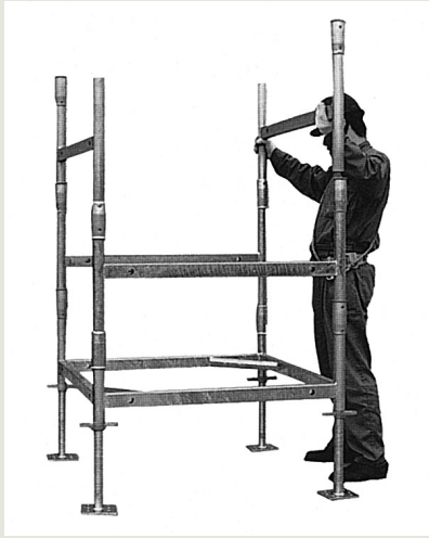
③スタッキングフレームを差し込みます。
