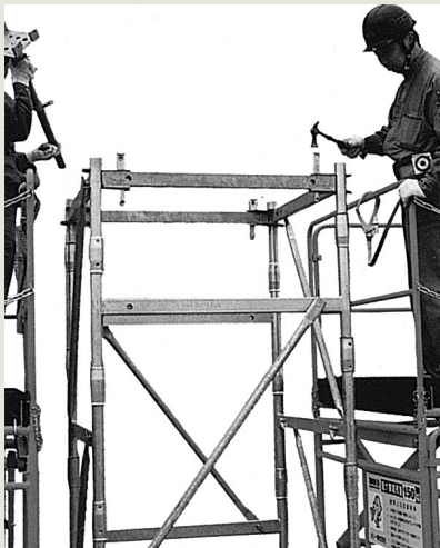
⑥エンドサポートを固定しヘッドスピンドルを差し込みます。
