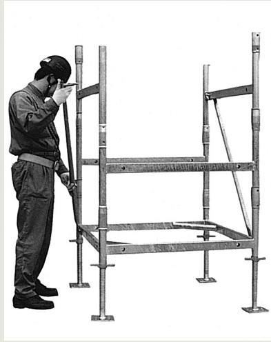
④ダイアゴナルストラットを取付けます。タワー上端部分になるまで③④の作業を繰り返します。高所では枠足場、高所作業台、高所作業車等を利用します。
