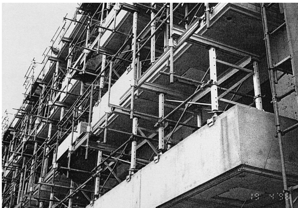
外部バルコニーショアー
